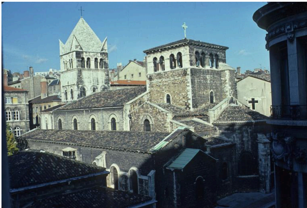
Vue d'ensemble prise depuis le sud-est
