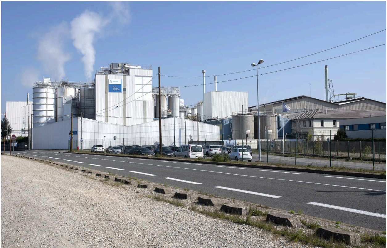
Vue d'ensemble ouest
