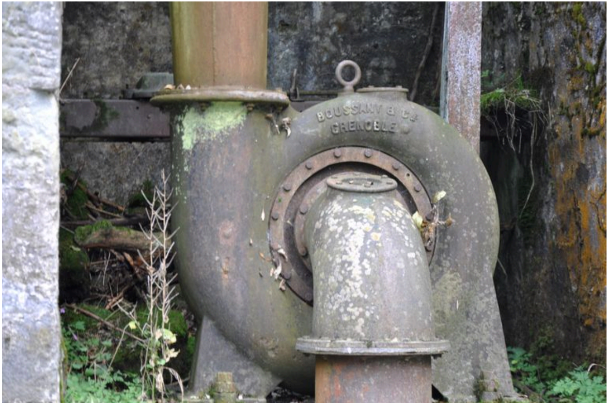
Détail de la turbine Boussant & Cie, Grenoble
