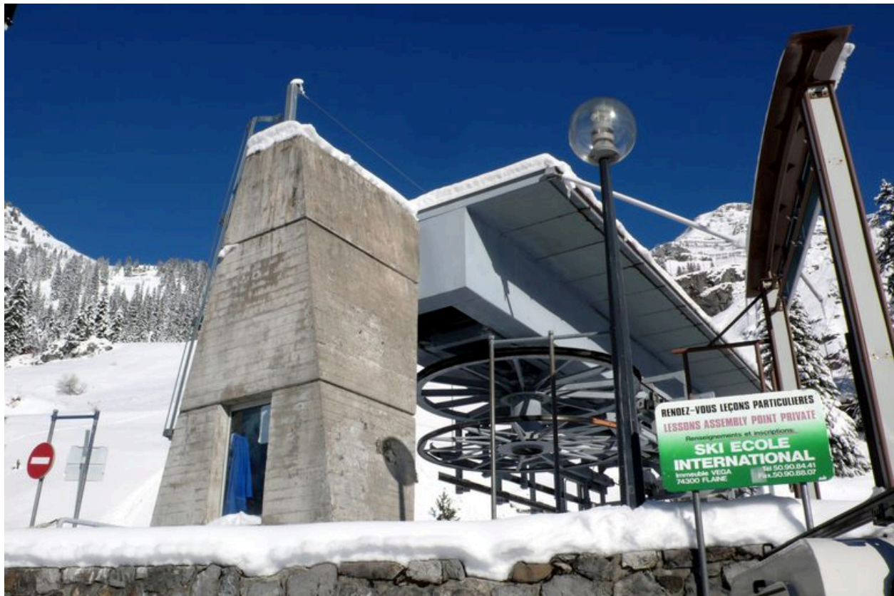
La gare inférieure de la télécabine des Grands Vans vue depuis le sud
