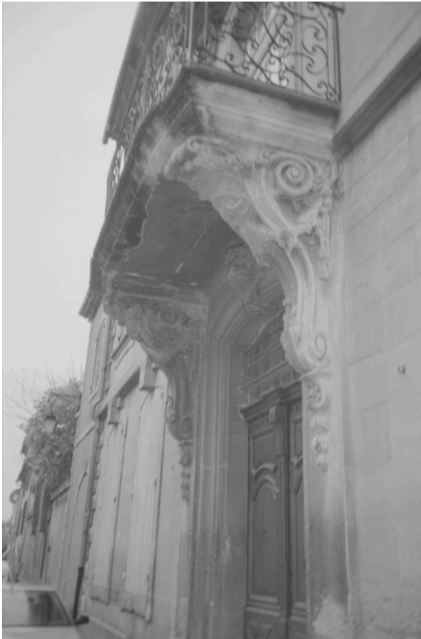
Façade sur rue, détail des consoles supportant du balcon de la travée axiale.
