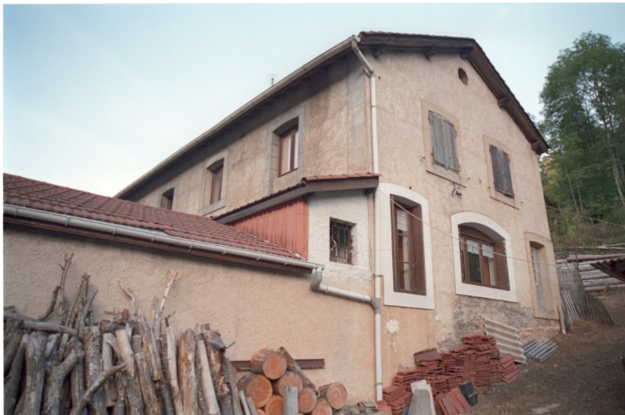
Hangar des chariots pour le transport des bouteilles avec écurie des chevaux et logement d'ouvrier, vue d'ensemble de l'élévation droite.
