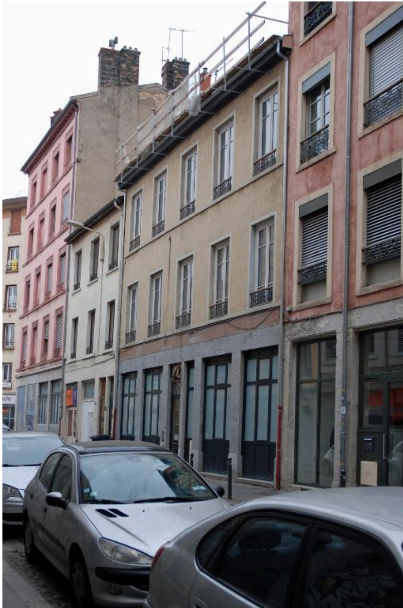
Vue d'ensemble, élévation sur rue
