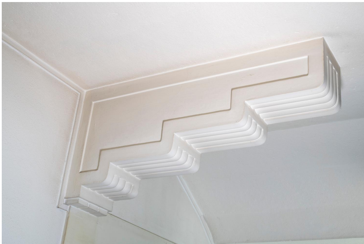
Rez-de-chaussée, cage de l'escalier sud : console moulurée
