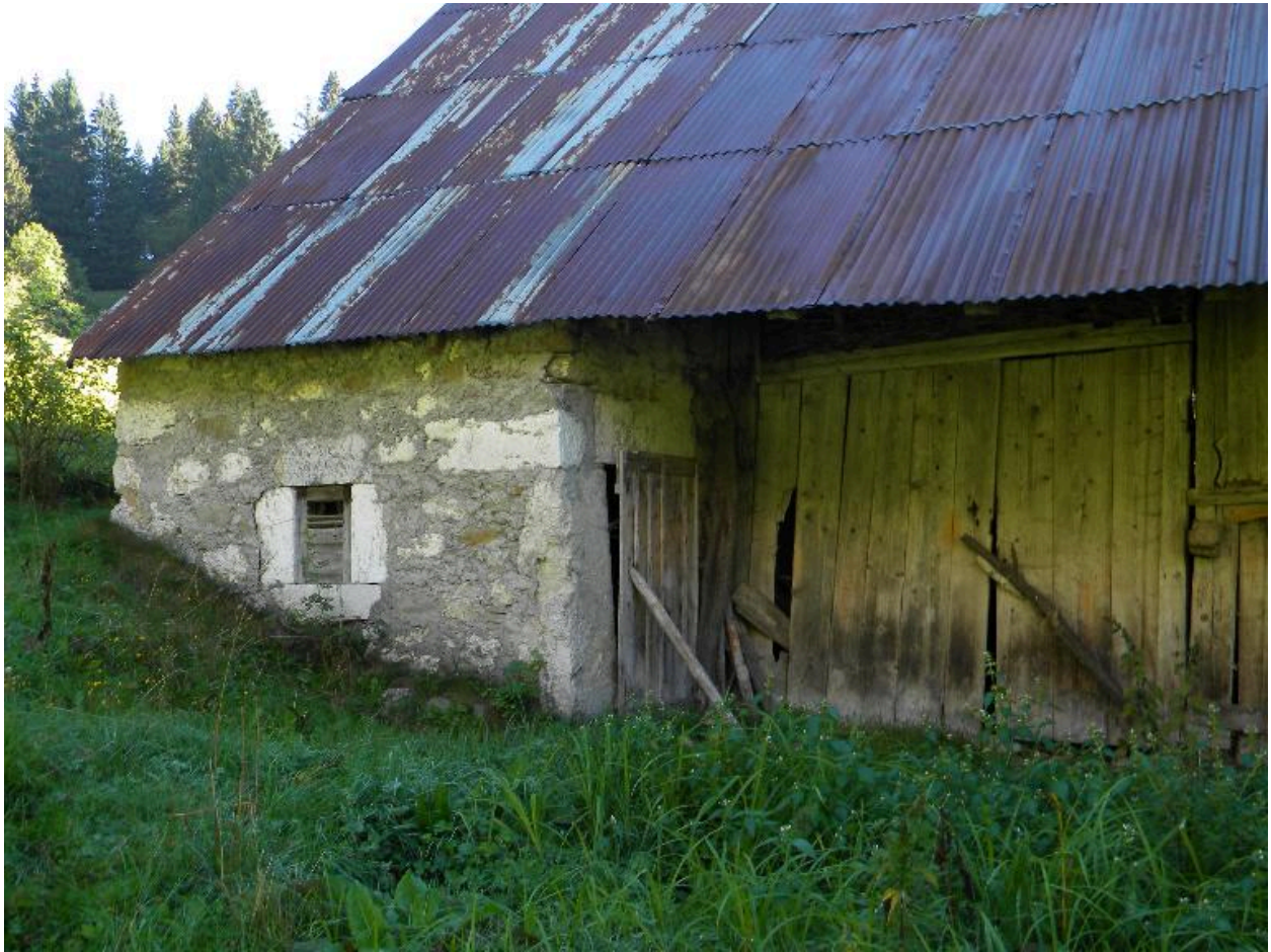
Vue de la partie logis en maçonnerie.
