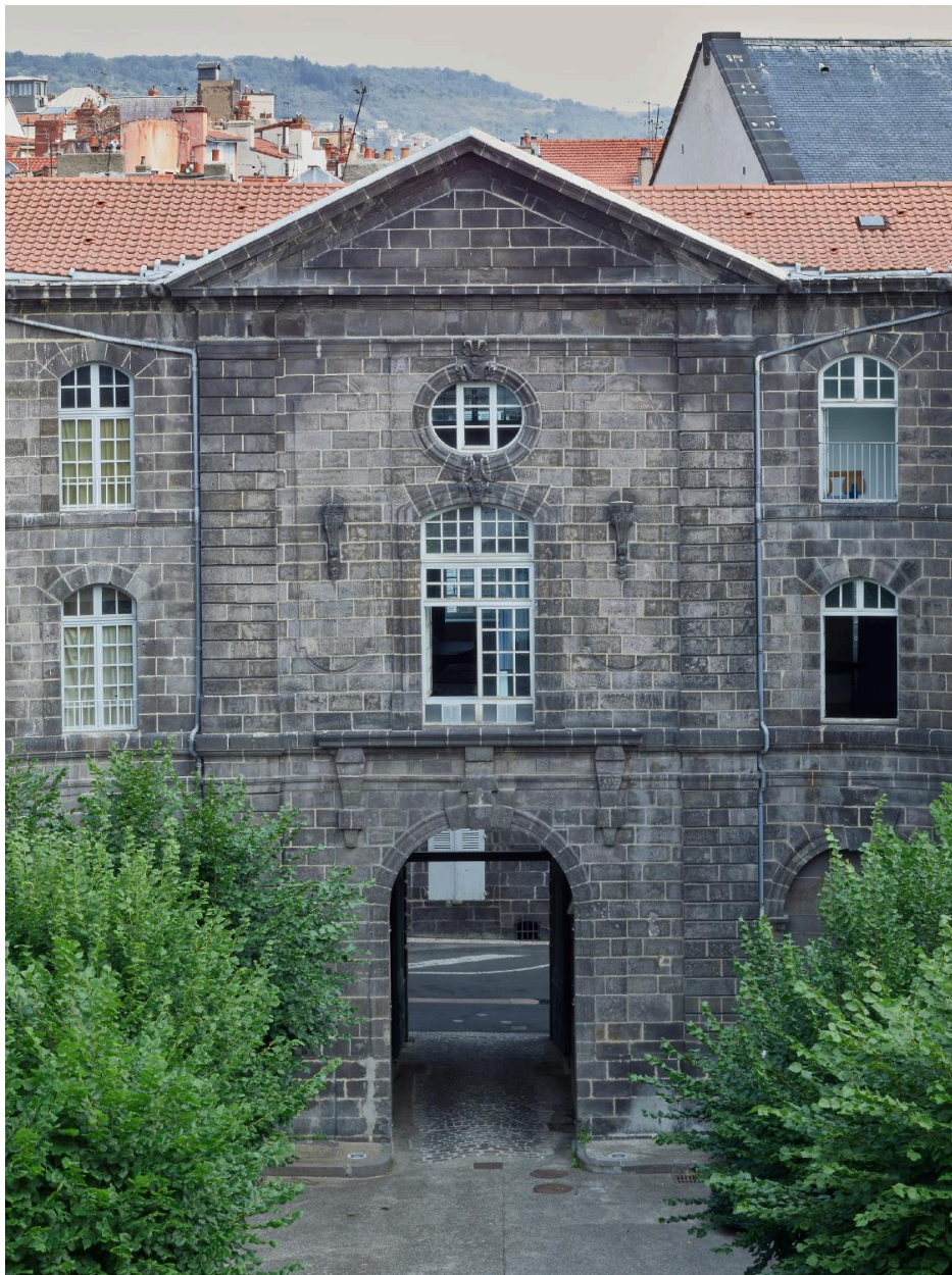
Bâtiment C : détail de l'élévation sur cour
