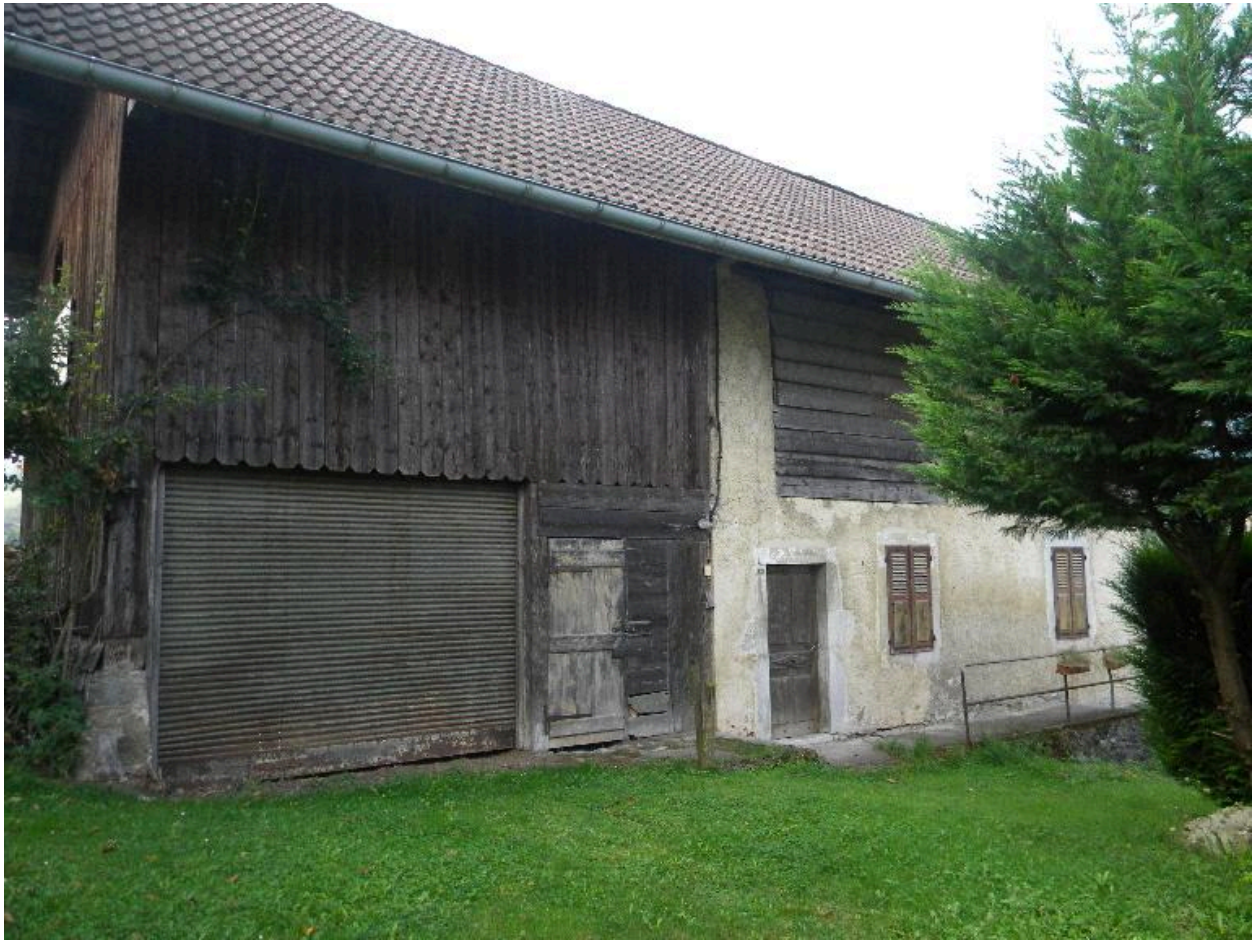
Vue de la façade nord.
