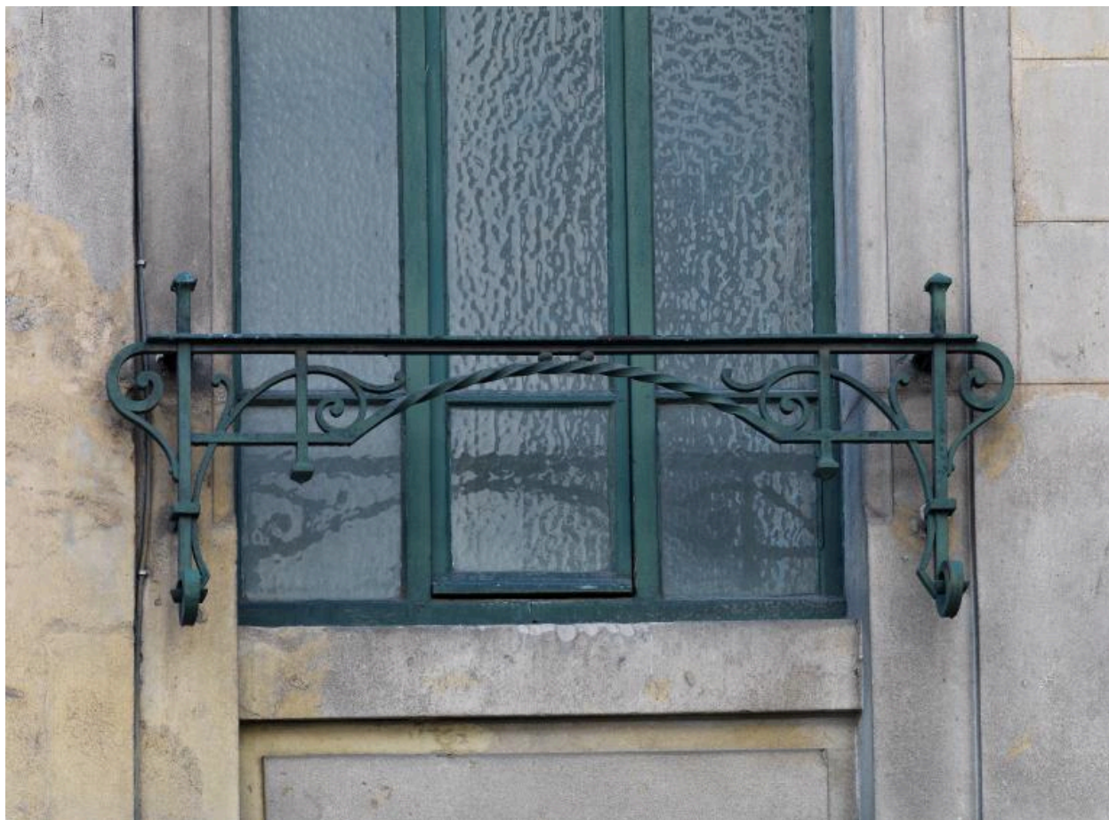
Elévation rue Hippolyte-Flandrin : détail d'un garde-corps
