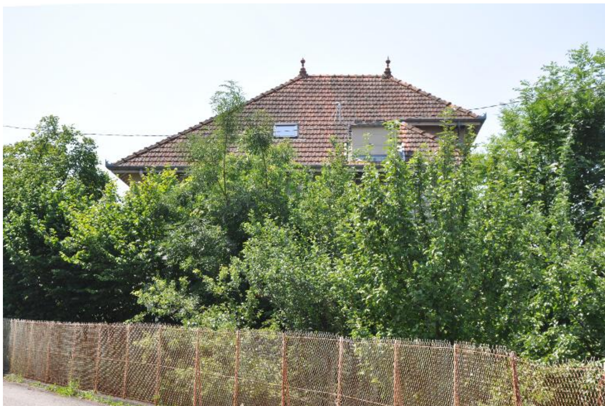
Vue générale de la toiture depuis le nord
