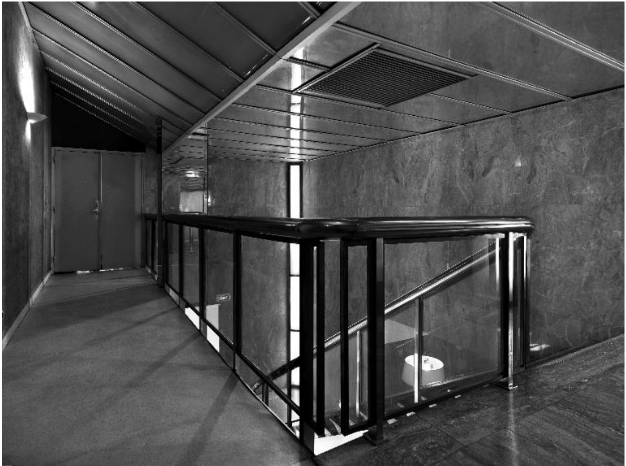
Escalier central, accès 1er étage bureaux
