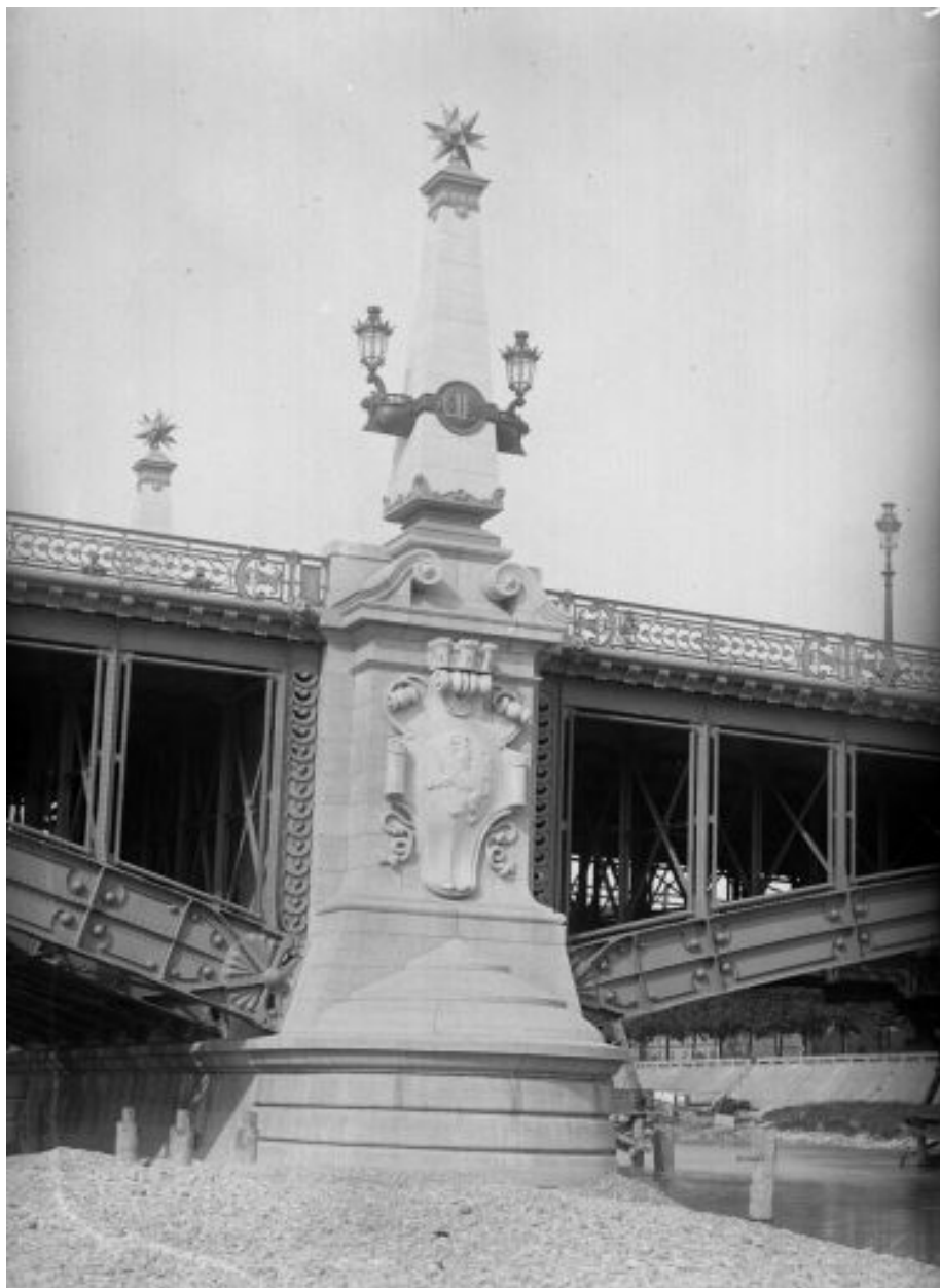
Détail d'une pile, fotogr. / E. Fabrègue et J.-E. Tardy, [1891] (AC Lyon : 0015 PH 1/904)
