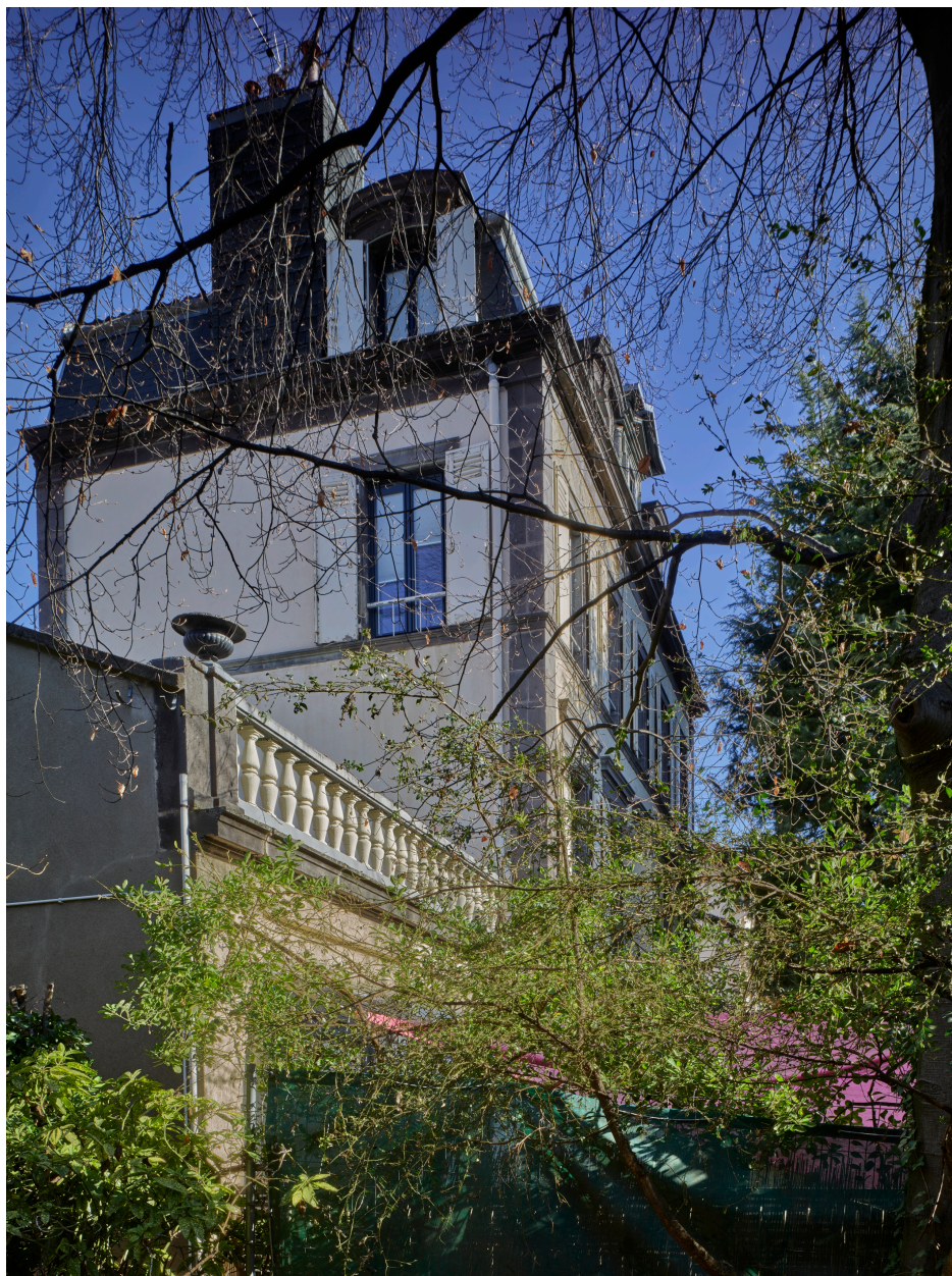
Angle du bâtiment voisin (90 bis, boulevard Lavoisier)
