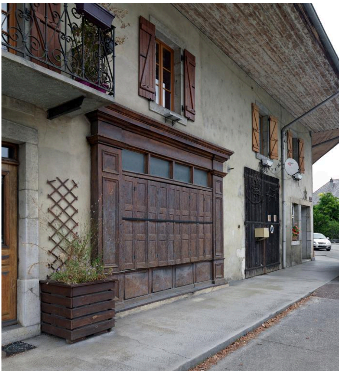
Vue d'ensemble de la façade sur rue.
