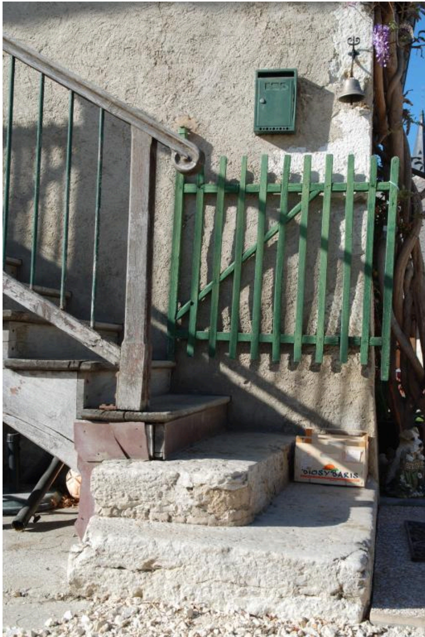
Façade principale sur cour, détail base de l'escalier.
