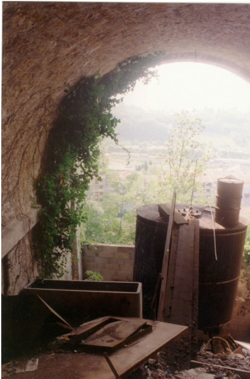
Une voûte de l'étage de soubassement
