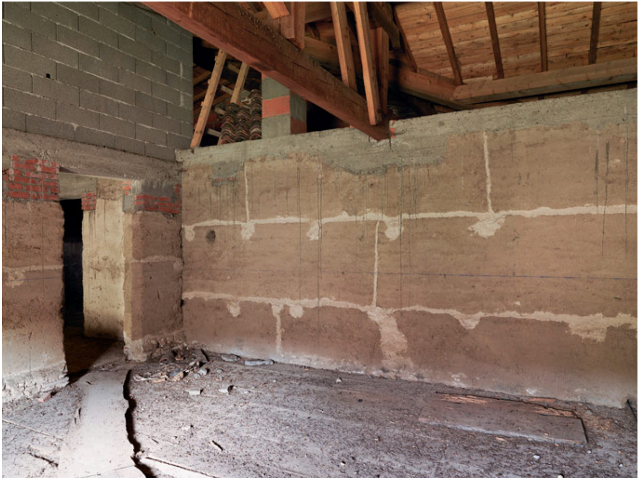
Vue intérieure du 2e étage : agrandissement sud.
