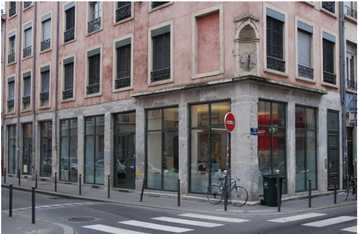
Vue rapprochée : rez-de-chaussée
