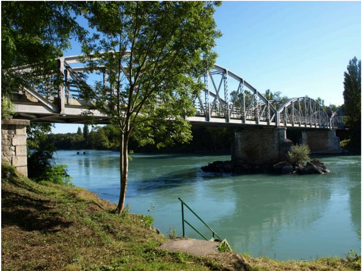
Vue générale, de côté, face aval (depuis la rive droite)
