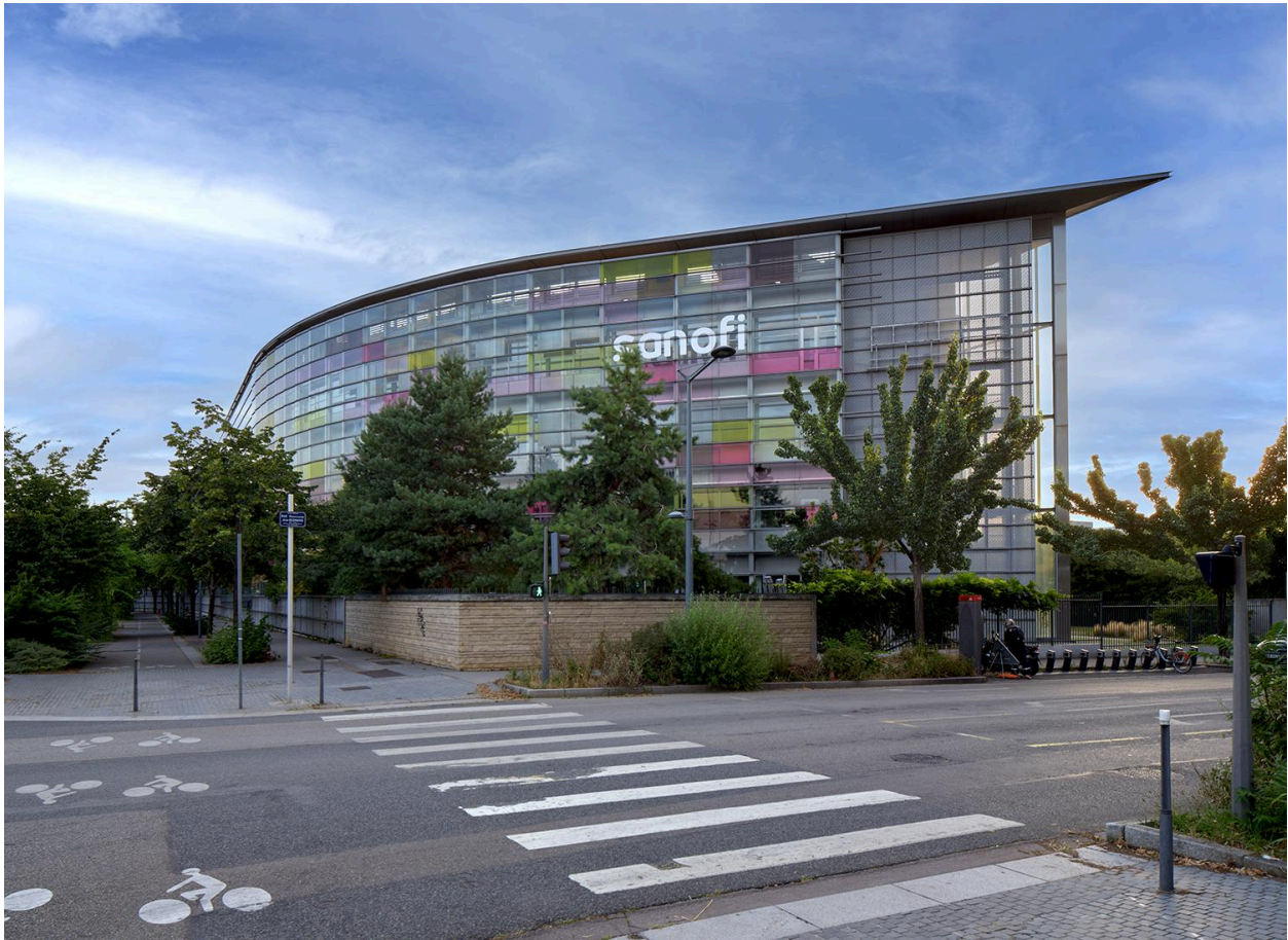
Vue sud de l'usine Sanofi, Gerland
