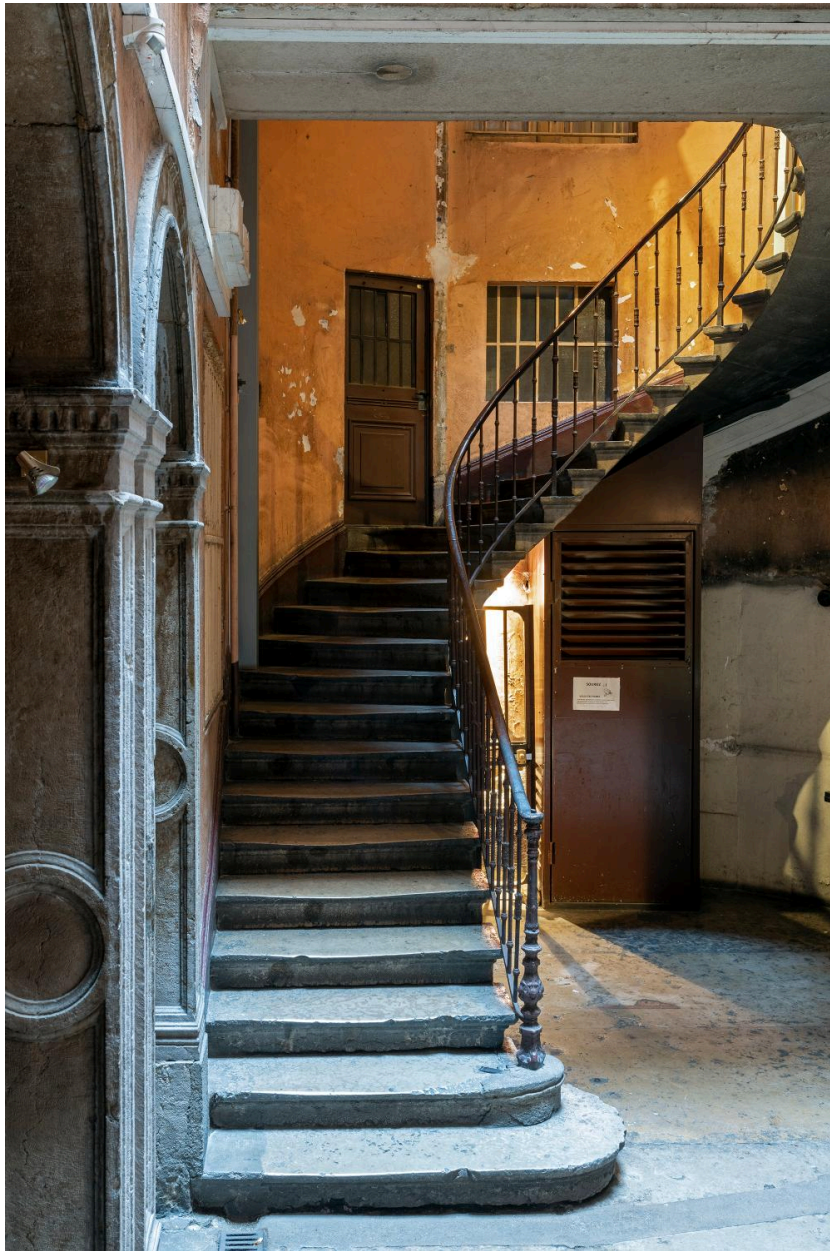
L'escalier sud : première volée et baies de la loge de concierge
