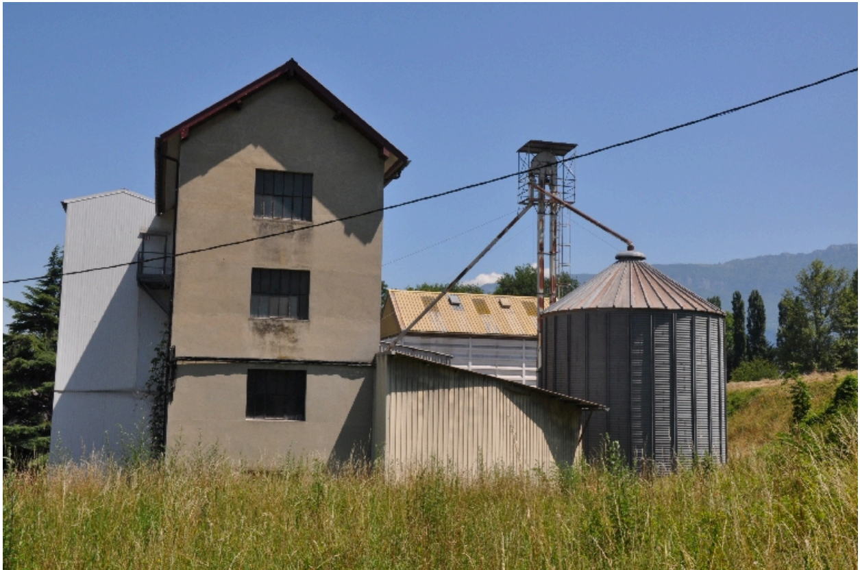
Vue sud de la minoterie depuis l'ancienne réserve d'eau
