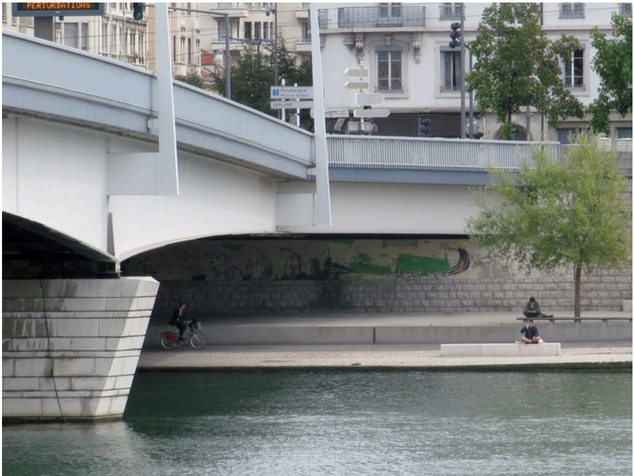
Travée et culée gauche, de côté, face aval, vue générale (depuis la rive droite)
