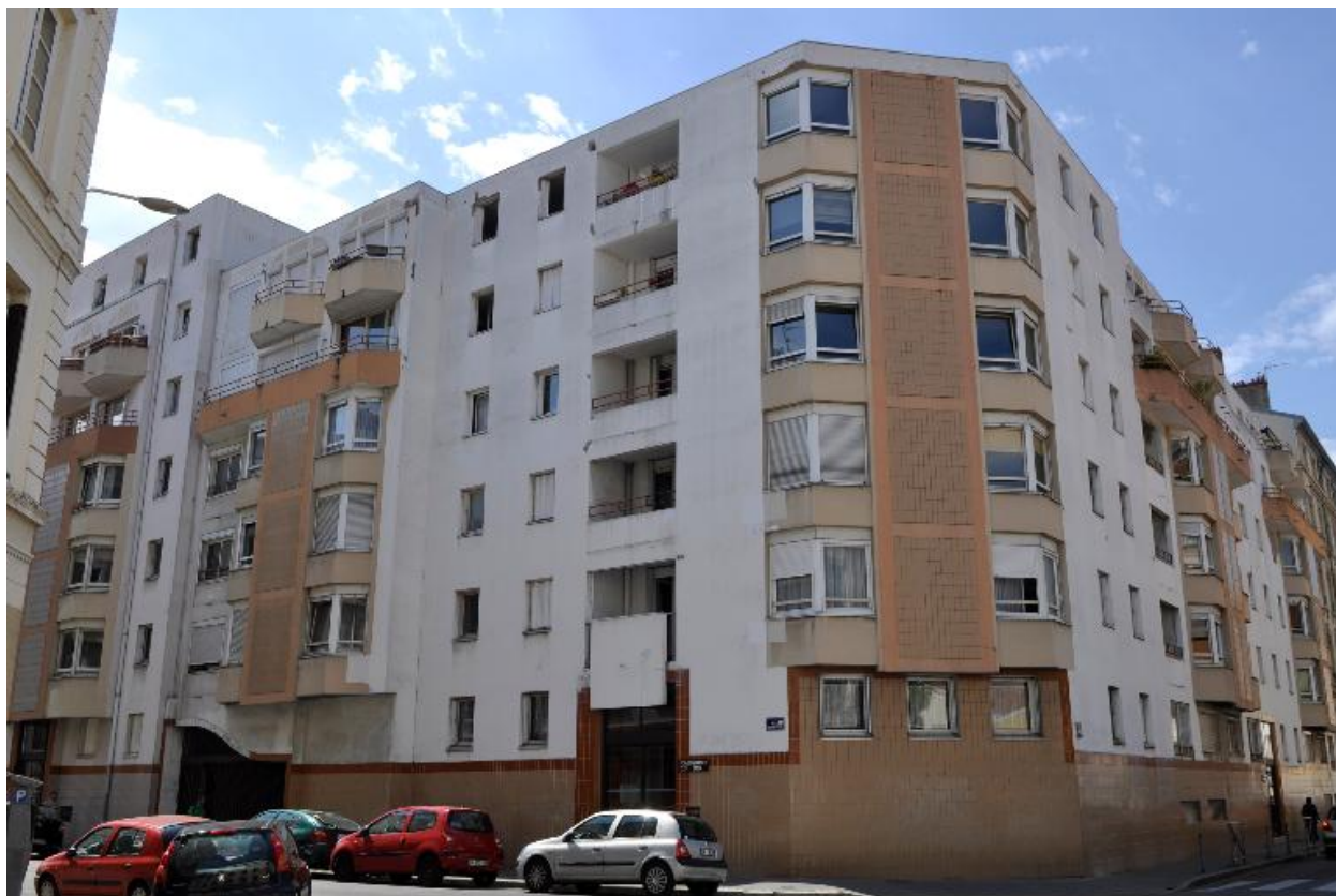
Vue d'ensemble, prise depuis le nord
