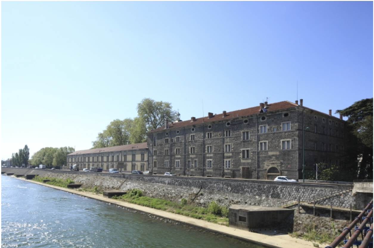
Vue d'ensemble des bâtiments du collège de Tournon depuis la passerelle Seguin. Au premier plan le bâtiment A 16e, en prolongement le bâtiment B, 19e.
