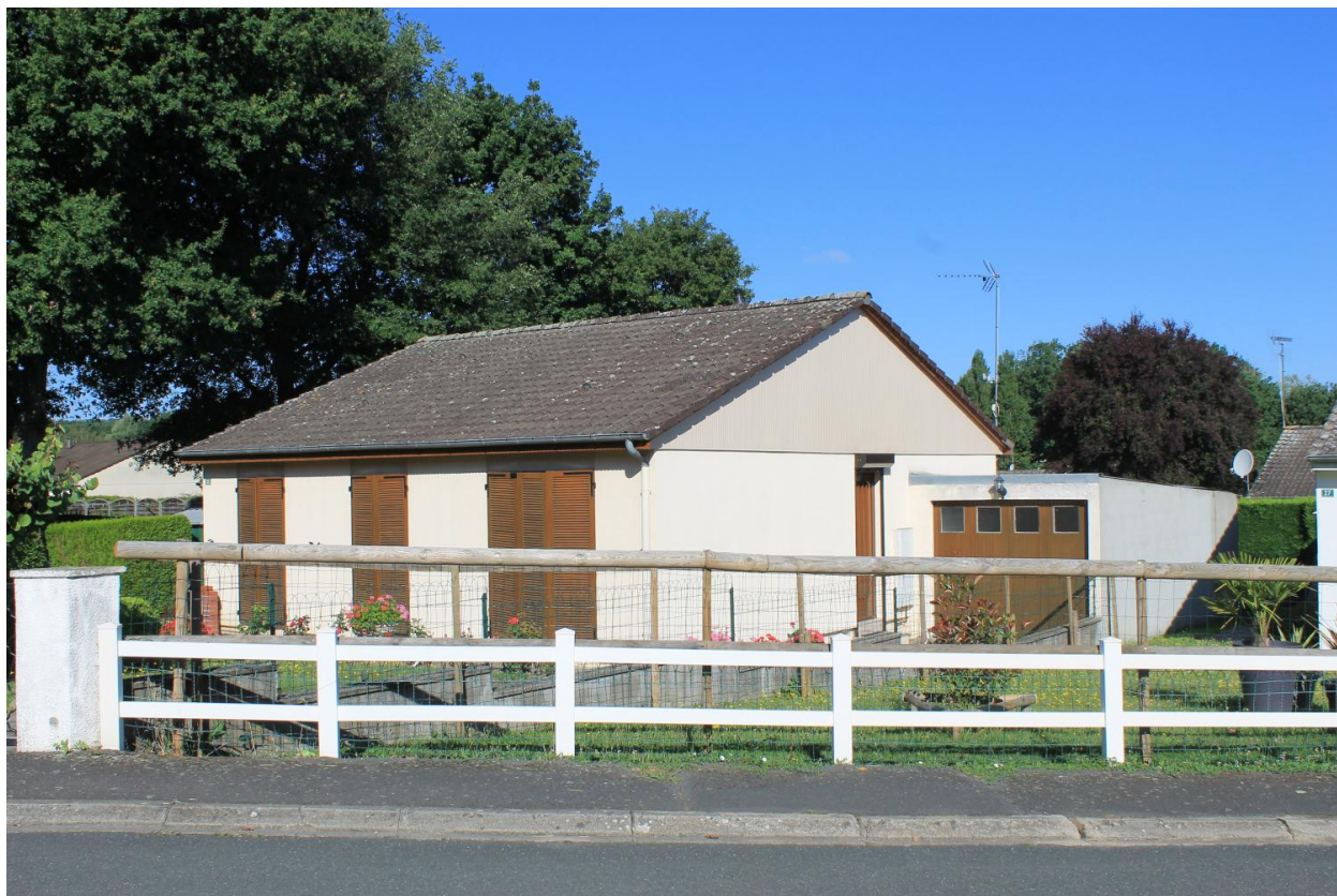
Domérat, lotissement de Bressolles, maison de type Rubis 4 sur vide-sanitaire, n° 25 rue Elsa-Triolet.
