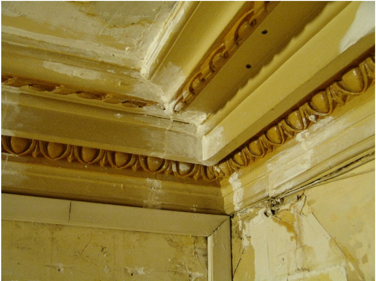
Hall : restauration de la corniche
