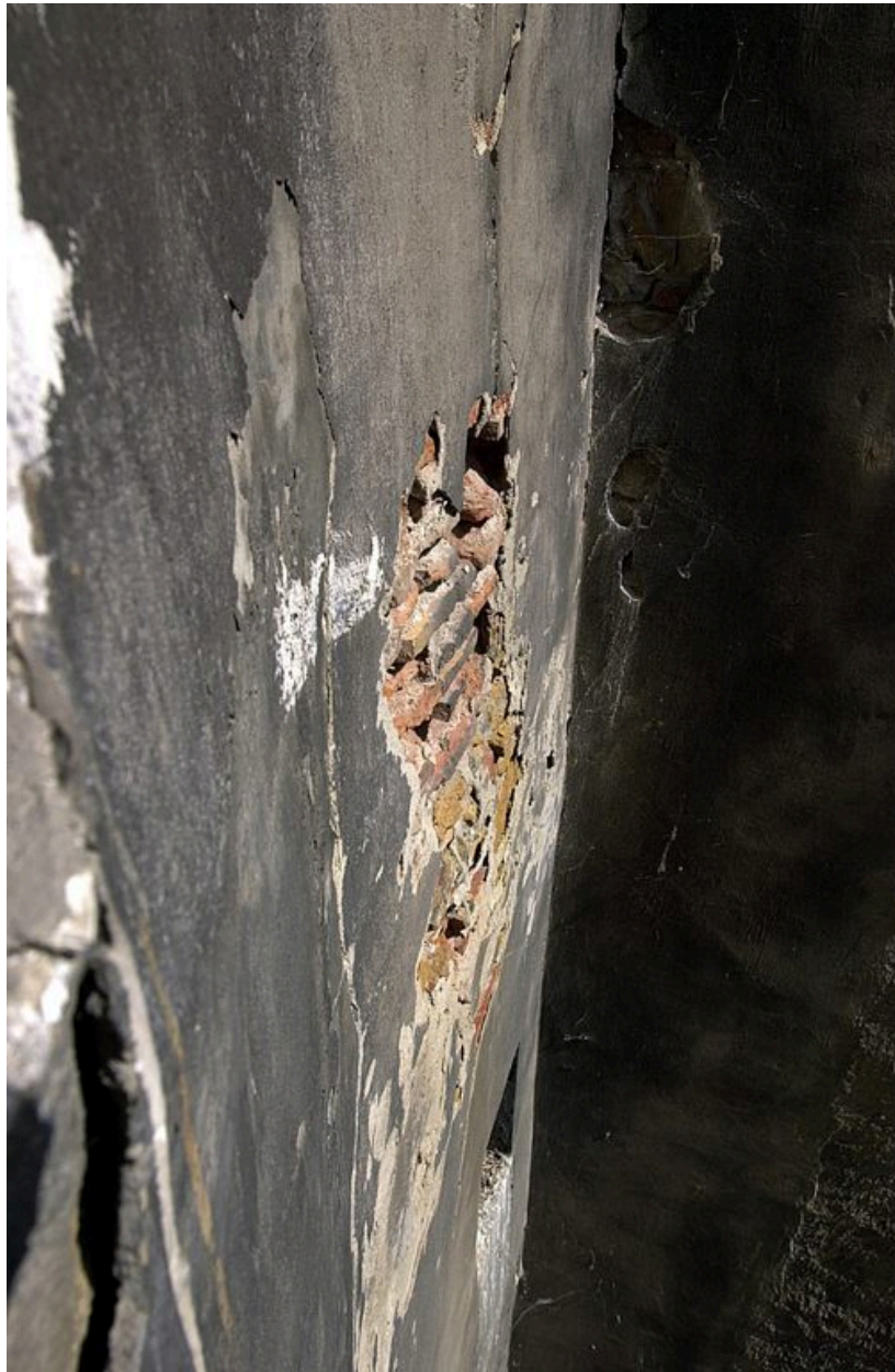
La cour, élévation ouest : détail de matériaux
