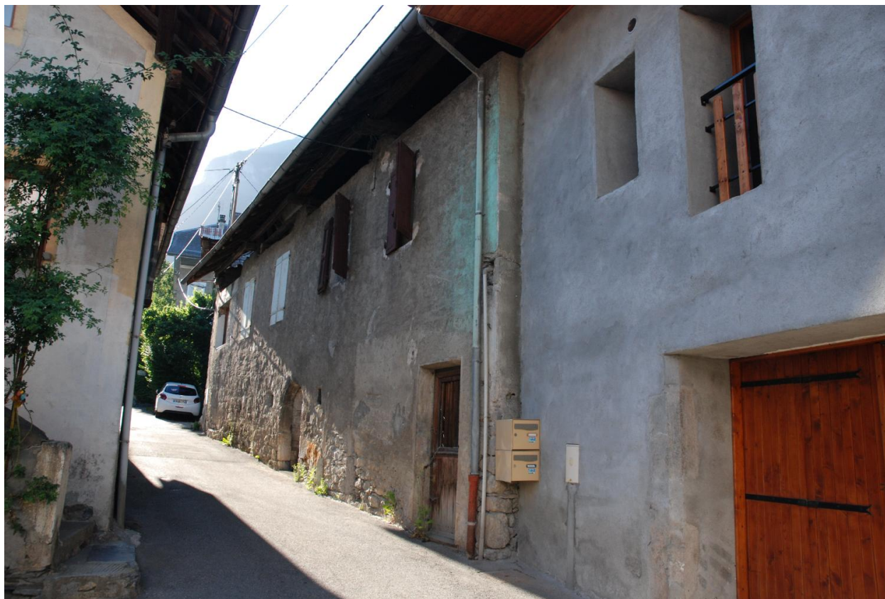
Maisons de vigneron (2018 I1 1769, 1663, 136), vue sud.
