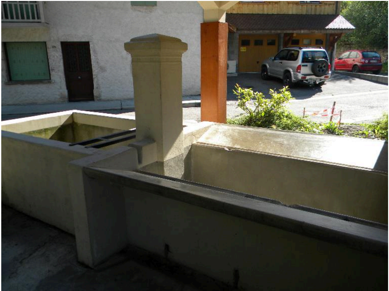
Vue rapprochée du lavoir couvert.
