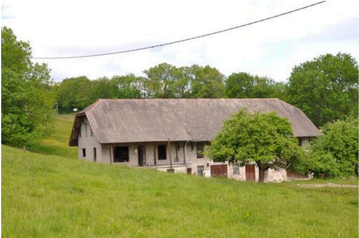
Elévation sud-est du bâtiment du moulin
