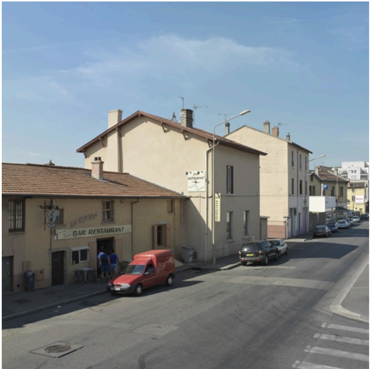
Vue d'ensemble est
