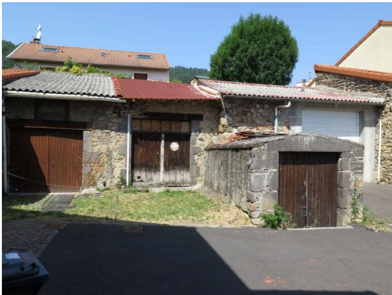
Descente de cave formant corps de bâtiment : Ceyrat, 10 rue des Vignerons
