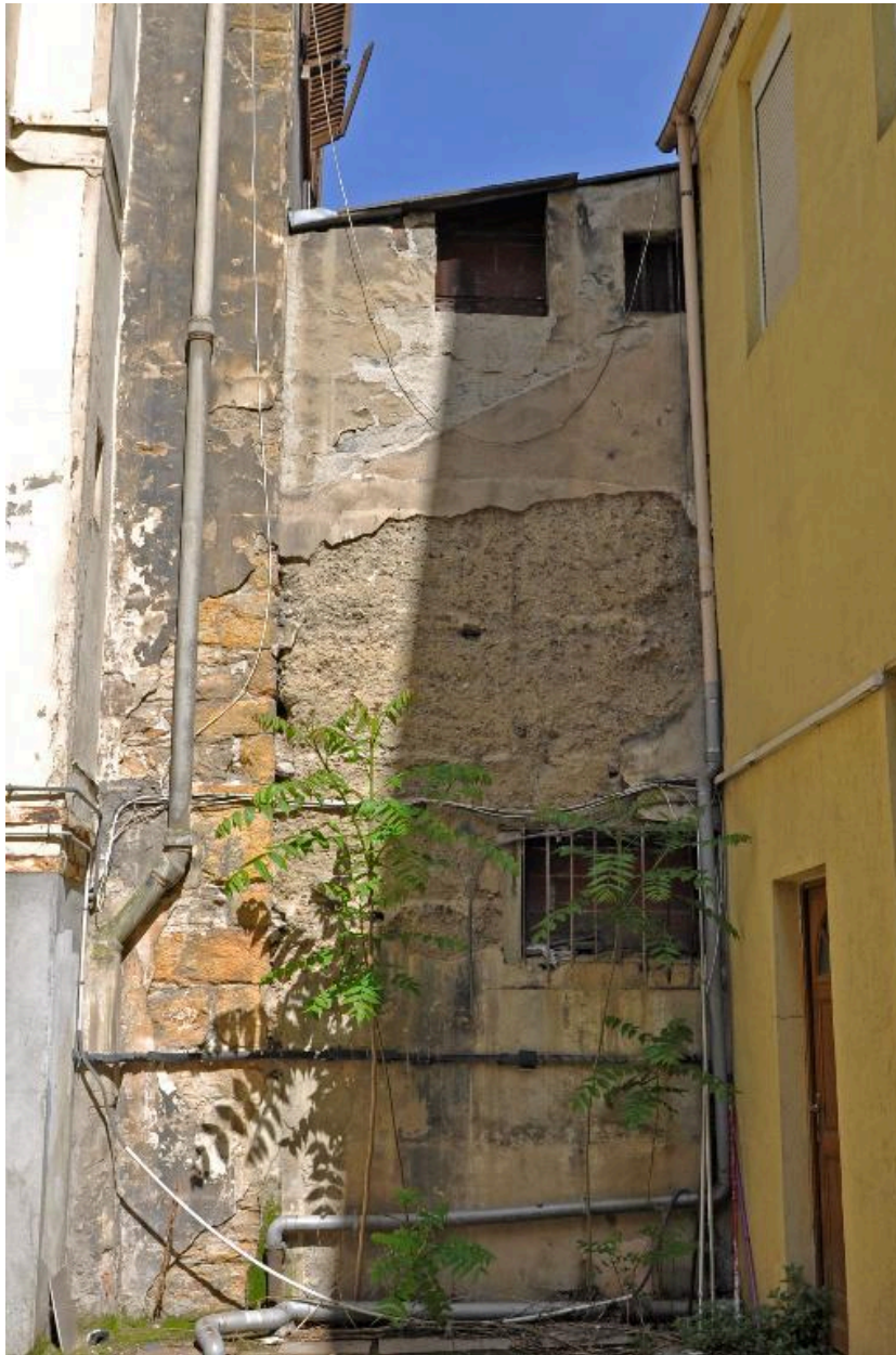
Atelier, mur postérieur en pisé (vu depuis la cour du 67 rue Reinach)
