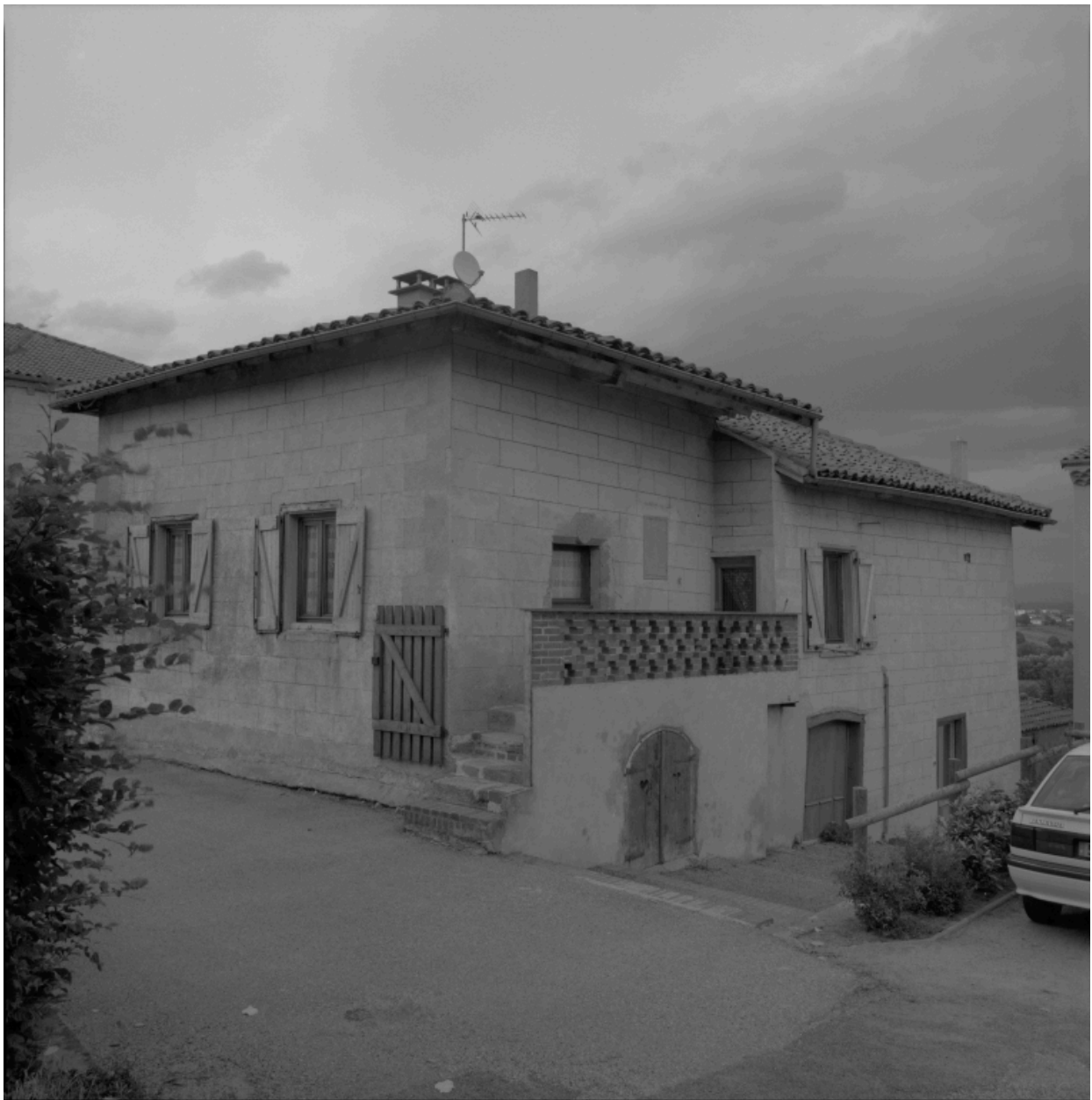
Ferme au bourg (ancien presbytère ? 1986 A1 76). Vue d'ensemble de trois-quarts depuis le sud.
