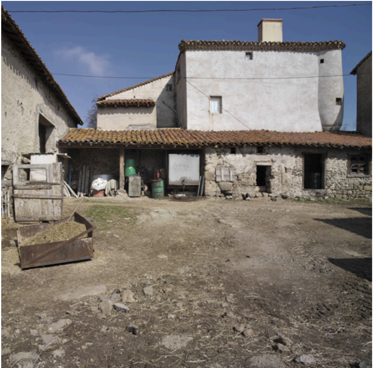
Vue latérale du logis, depuis le sud.
