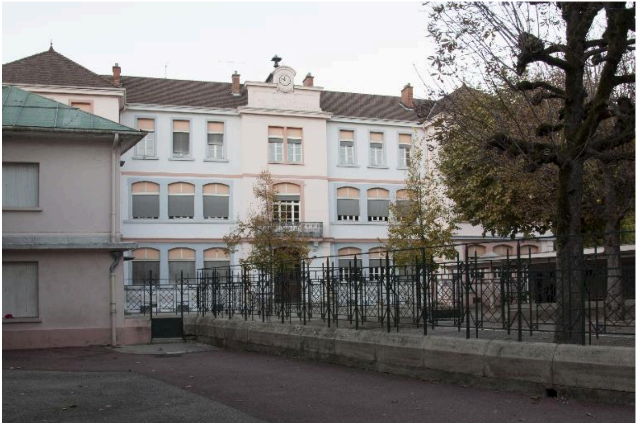
Vue d'ensemble : façade principale et cour
