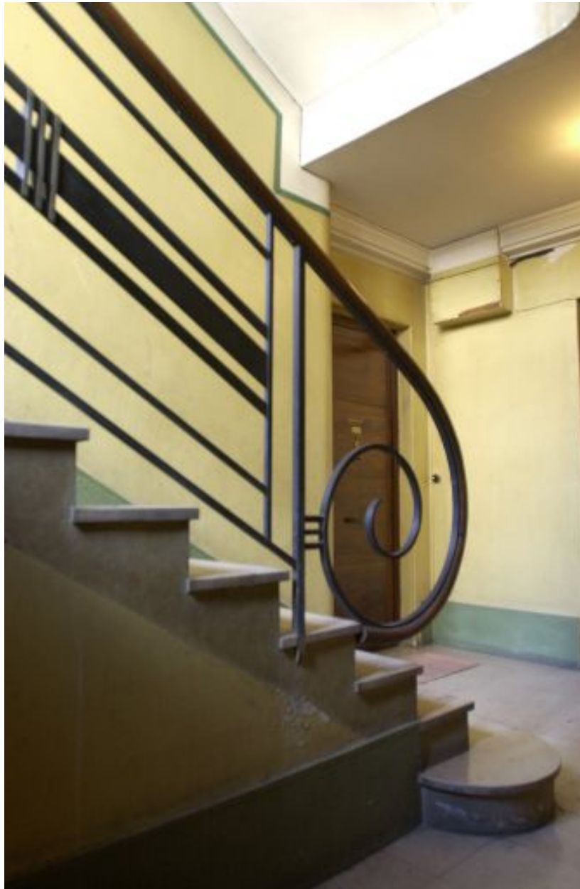
Détail de la rampe d'escalier, 54 rue Smith
