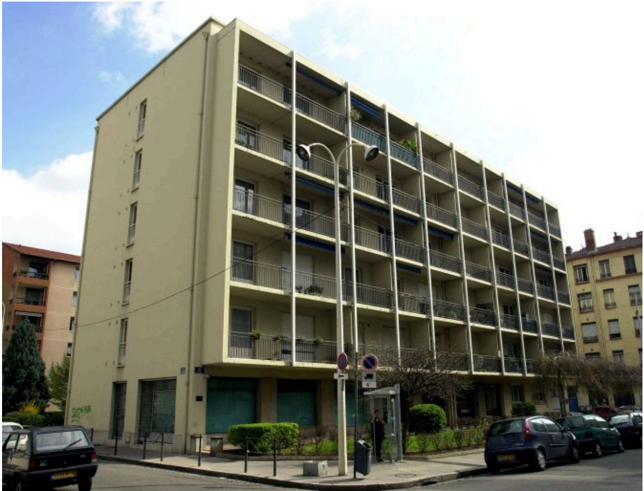
Élévation principale depuis le sud-ouest
