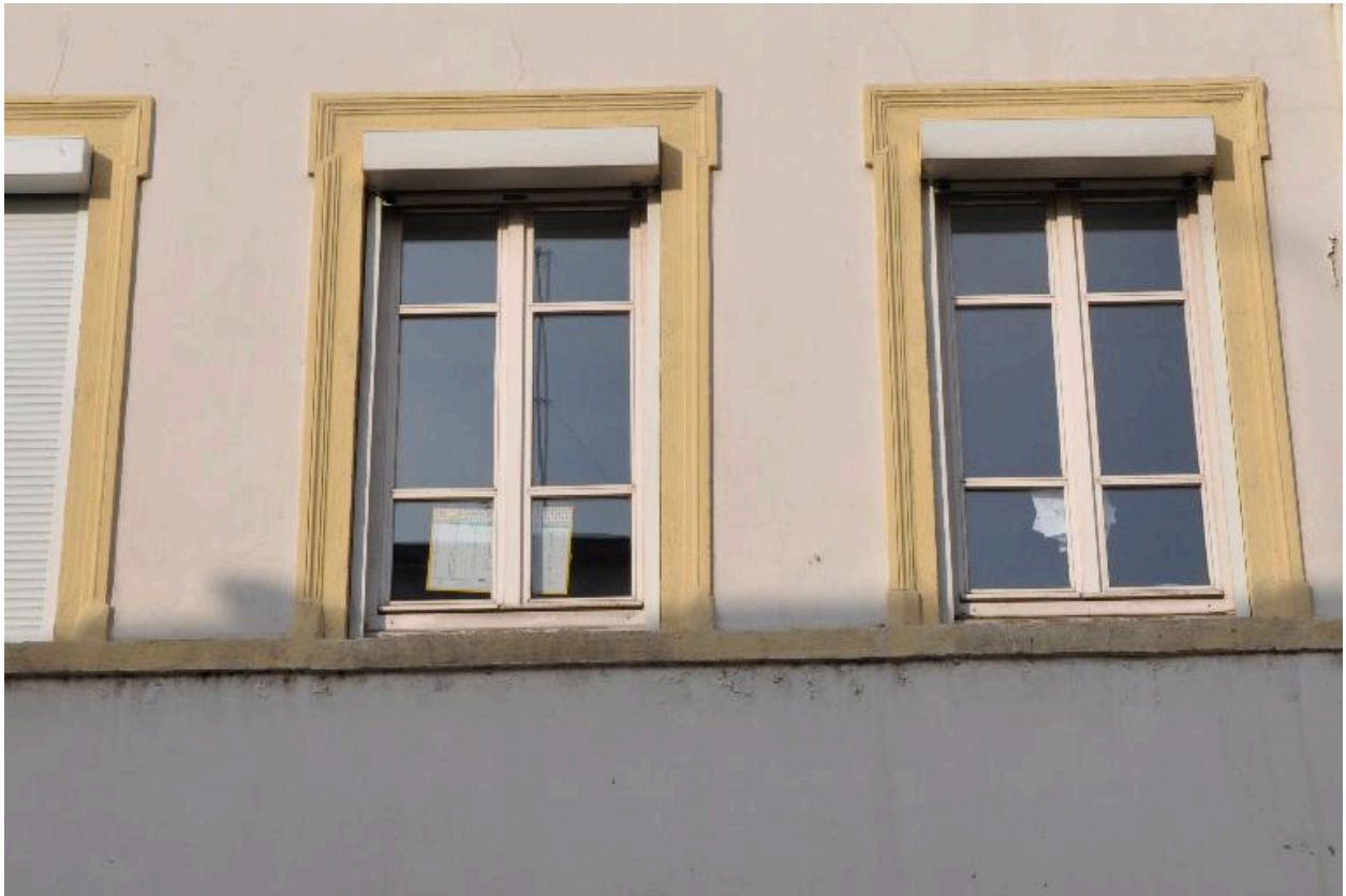
Elévation sur rue, encadrements de baies à crossettes
