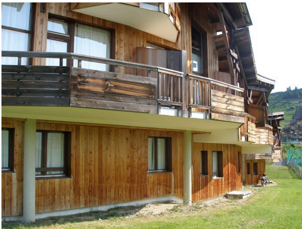
Détail du balcon central de l'élévation postérieure
