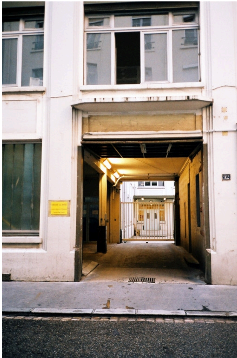
Entrée nord rue de Montesquieu
