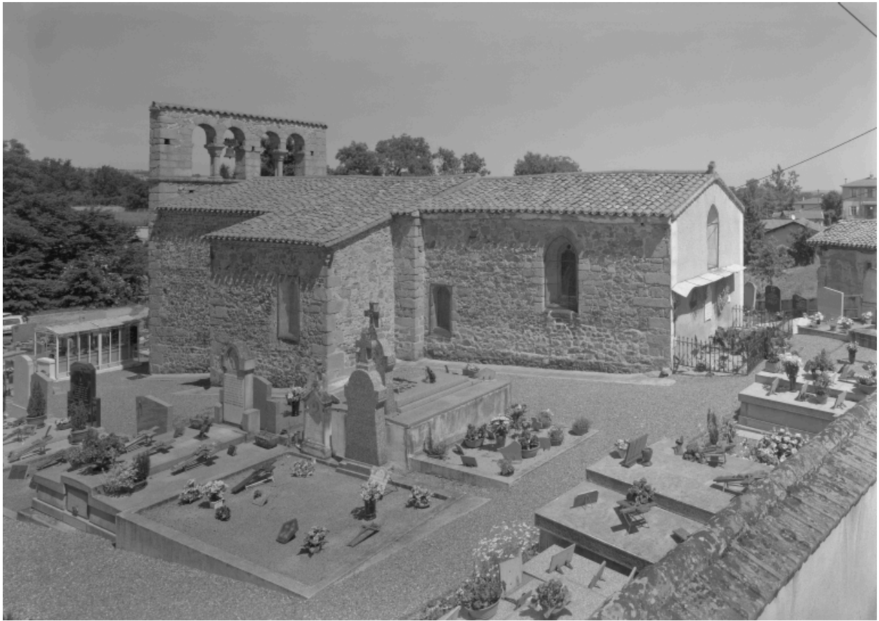
Vue générale de trois-quarts arrière, depuis le sud-est.
