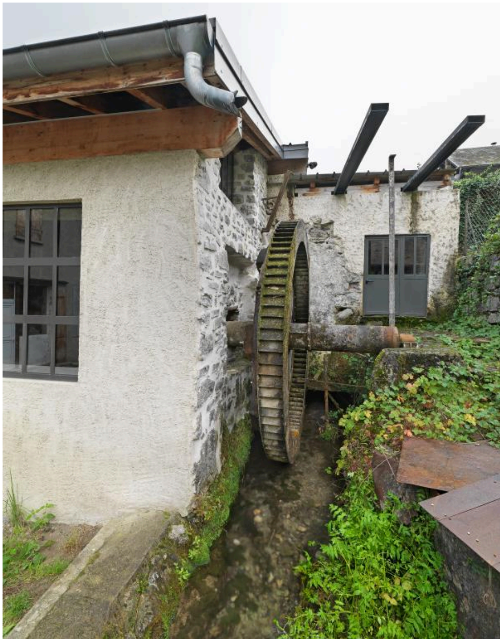
Vue de la grande roue hydraulique, 2019.
