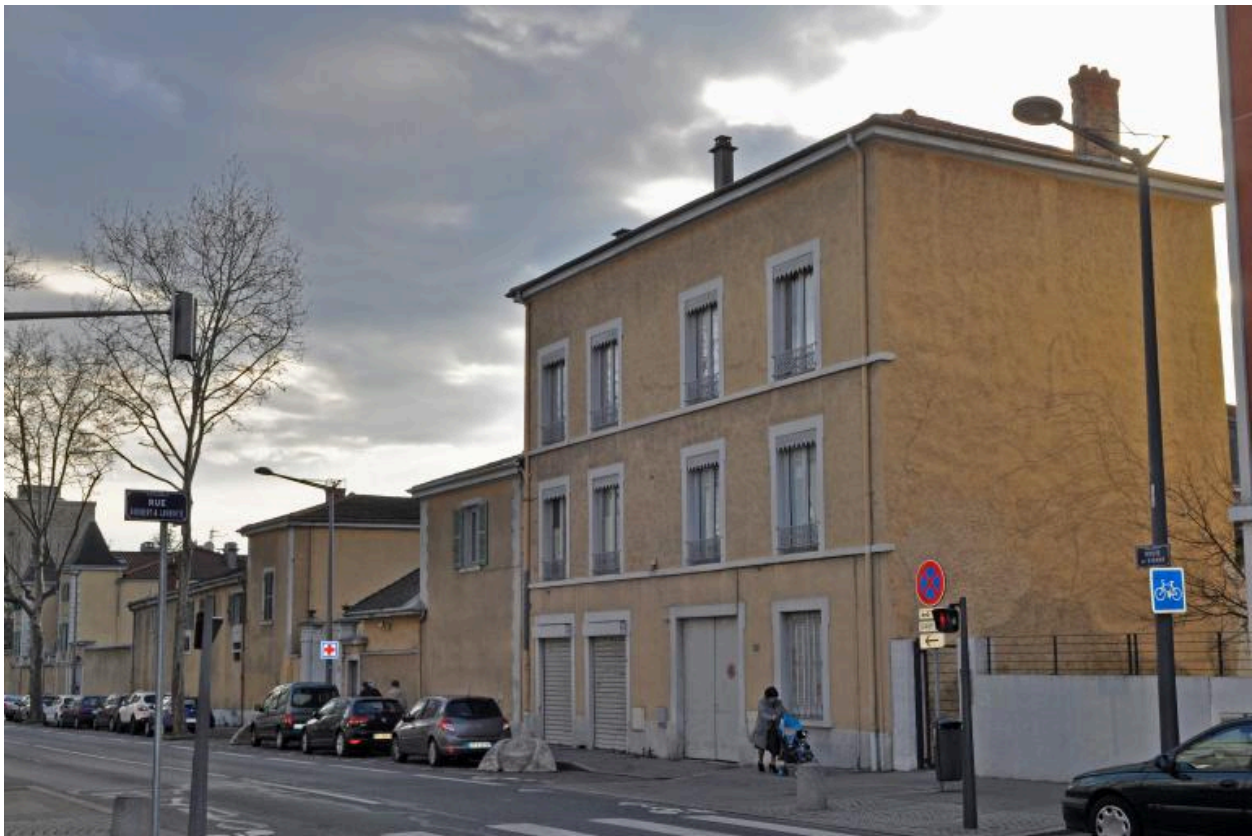
Vue de situation, depuis le nord, prise avant l'effondrement de l'immeuble au premier plan
