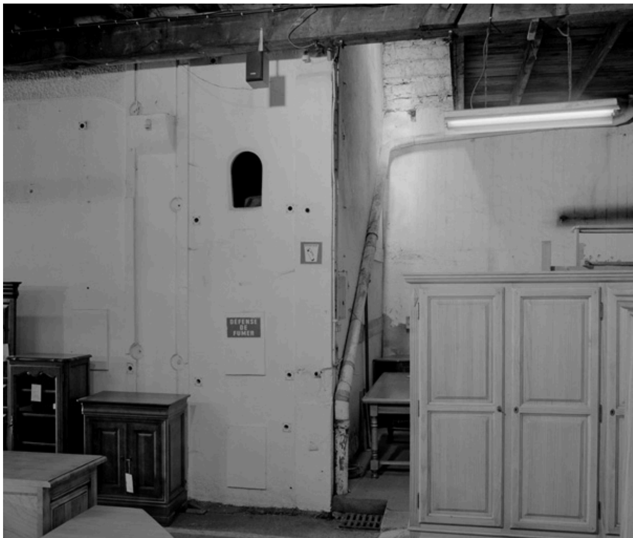
Façade de cuve : détail jour
