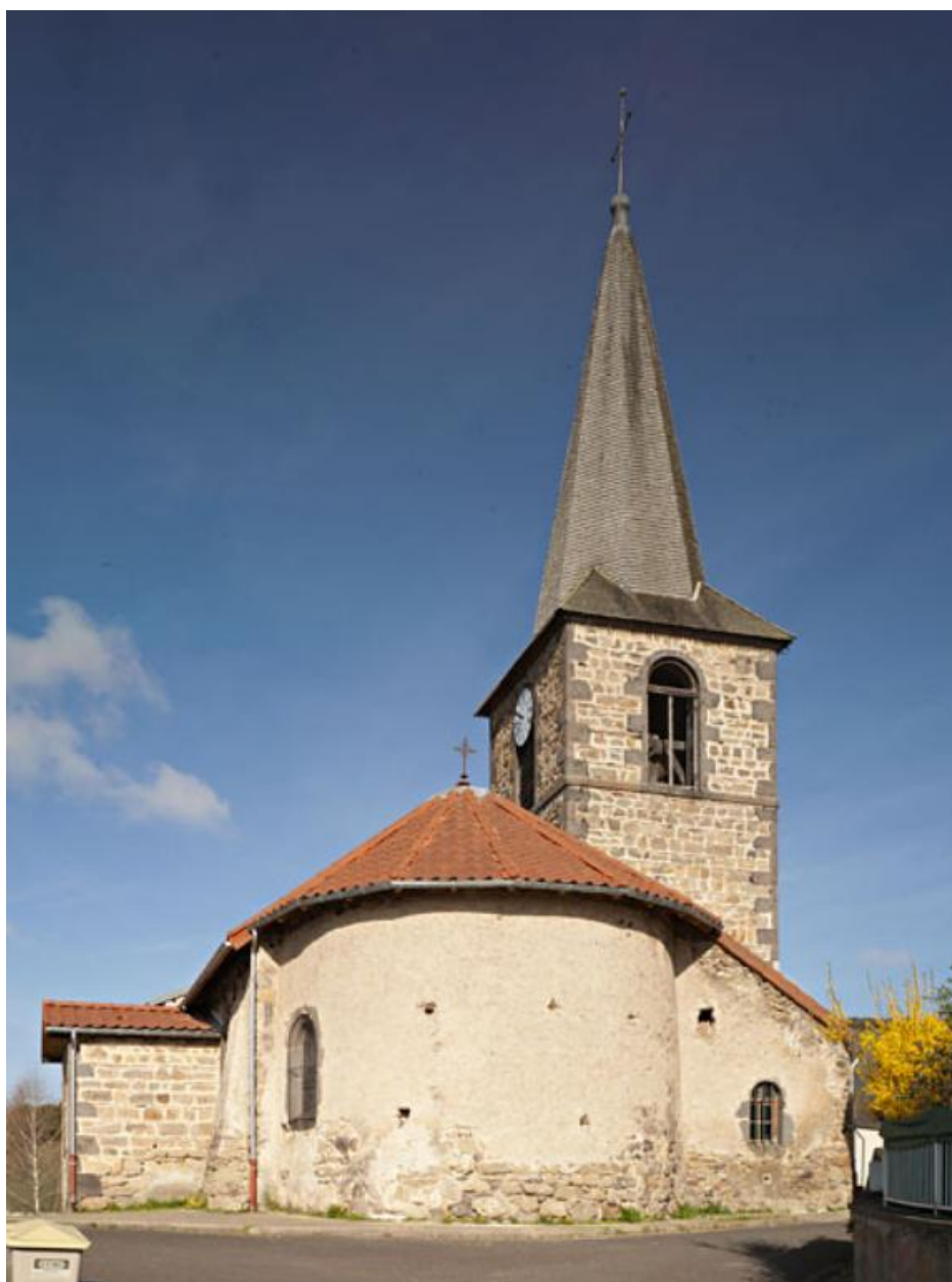
Vue générale du chevet.
